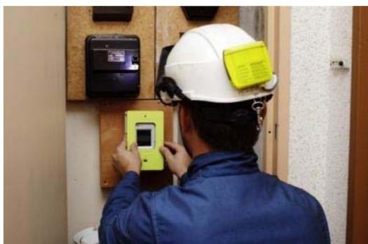
Pour réduire les consommations, une directive européenne de 2009 impose l'installation, chez tous les usagers, de compteurs d'énergie « communicants ». Fondation de l'édifice des réseaux intelligents, ces compteurs de nouvelle génération offrent de nouveaux services : télé relevés, changement de puissance et mise en service à distance, facture sur la base de la consommation réelle, délais d'intervention réduits, facilitation du diagnostic en cas de panne.
